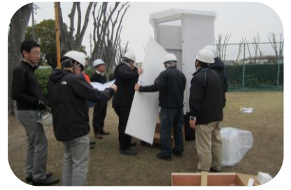
防災トイレ設置
